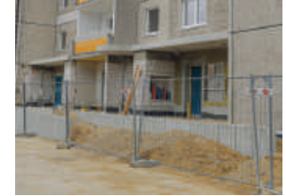
Umbau der Erdgeschosszone
