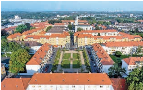
Köln-Bickendorf, Am Rosenhof Modernisierung Wohnsiedlung 1920/30er Jahre Bauherr: GAG Immobilien AG, Köln Planung: Forstbach Consulting, Köln
