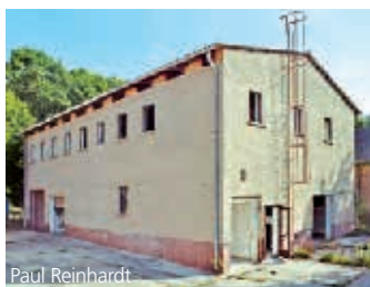
Vor der Umnutzung: Lagerhaus aus den 1980er Jahren
