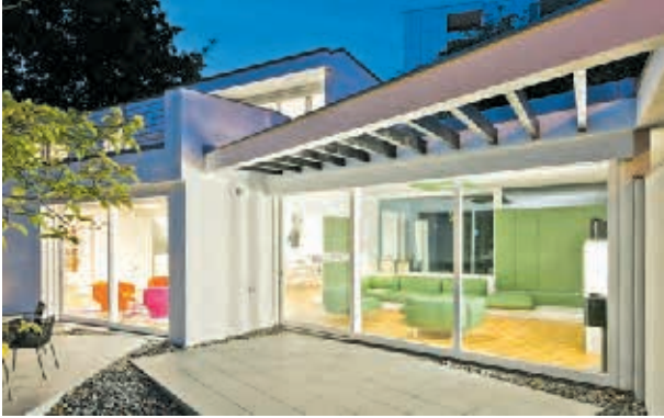
Berlin Hansaviertel, Händelallee Modernisierung Haus Blumenthal Bauherren: Dr. Stefan und Kerstin Morschheuser Planung: wiewiorra hopp schwark architekten BDA, Berlin
