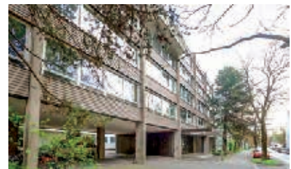
Neue hochwärmegedämmte Brüstungselemente und Fenster im EnEV-Standard
