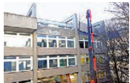
Abbruch der Betonfertigteilbrüstungen
