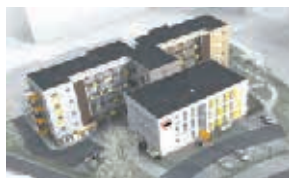
Neue Nutzung der Schule
