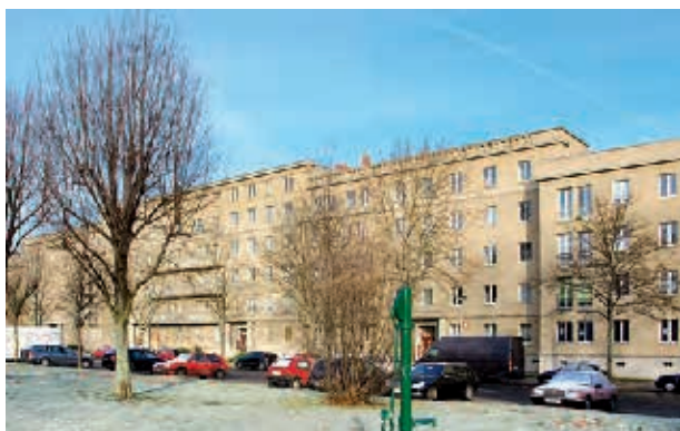
Berlin-Prenzlauer Berg, Mandelblock Wohnquartier der 1950er Jahre Bauherr: Gewobag PB Wohnen in Prenzlauer Berg GmbH, Berlin Planung: iwB Ingenieurgesellschaft mbH, Berlin
