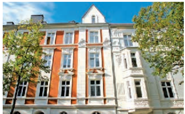
Dortmund, Chemnitzer Straße / Sonnenstraße Modernisierung Wohndenkmal Bauherr: Spar- und Bauverein eG, Dortmund Planung: Spar- und Bauverein eG, Dortmund
