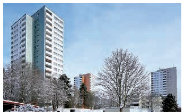
Ulm-Böfingen, Elchinger Weg Modernisierung der 3 Wohnhochhäuser aus den 1960er Jahren Bauherr: Ulmer Wohnungs- und Siedlungs-Gesellschaft mbH Planung: 4a Architekten GmbH, Stuttgart
