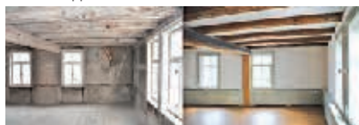
Wohnung vor und nach der Sanierung
