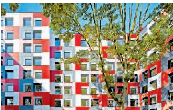
Essen-Kray, Eckenbergstraße Modernisierung Studentenwohnheim Bauherr: Studentenwerk Essen-Duisburg AöR Planung: Architektur Contor Müller Schlüter, Wuppertal
