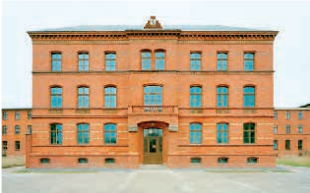
Berlin, Hauptstraße Umnutzung Kaiserliches Arbeitshaus Bauherr: Planungsgesellschaft Hauptstraße 8 GbR Planung: AFF Architekten, Berlin
