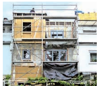
Sanierung der Fassade: Holzständerkonstruktion mit Holzfaserdämmstoffen
