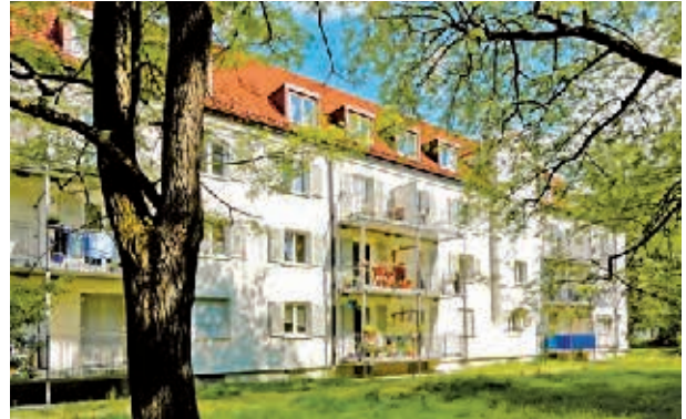
München, Neuhausen Nord III Modernisierung der Großsiedlung aus den 1920/30er Jahren Bauherr: GEWOFAG Wohnen GmbH, München Planung: Maier.Neuberger.Architekten GmbH, München
