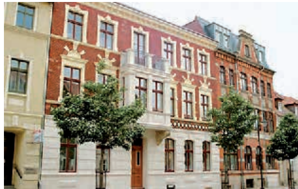
Bad Liebenwerda, Mittelstraße Sanierung der historischen Reiss-Häuser Bauherr: Haus- und Grundbesitzgesellschaft Bad Liebenwerda Planung: Ulrich Sasse Architekten und Ingenieure, Cottbus
