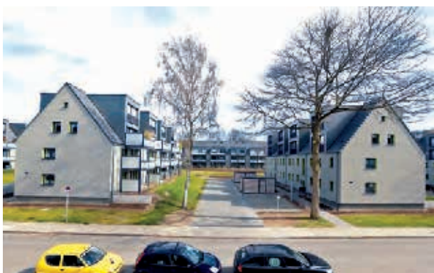
Hattingen, Klimaschutzsiedlung Wohnsiedlung der 1950er Jahre Bauherr: hwg eG, Hattingen Planung: Volker Thein, Bochum
