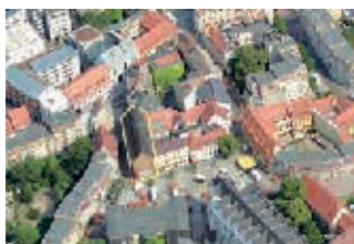
Lage des Gebäudes
