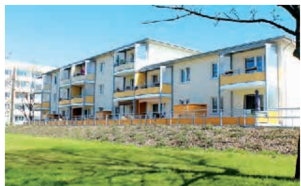
Aschersleben, Staßfurter Höhe Rückbau Plattenbau (5 Geschosse auf 2-3 Geschosse) Bauherr: Ascherslebener Gebäude- und Wohnungsgesellschaft Planung: Ingenieurbüro Töpfer + Girnth, Staßfurt
