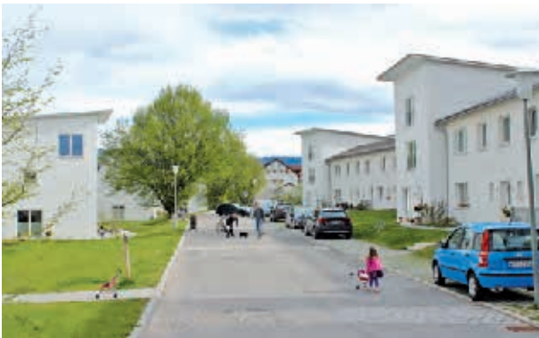
Murnau, Gartenstadt Michaelstraße Umbau/Anbau Reihenhäuser (Ende der 1950er Jahre) Bauherr: Peter Ottmann, München Planung: Peter Ottmann und Daniel Ritthammer, München
