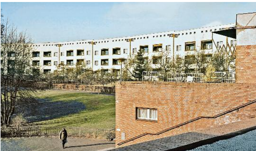
Hufeisensiedlung, Berlin, gebaut ab 1925 nach Planung von Bruno Taut und Martin Wagner
