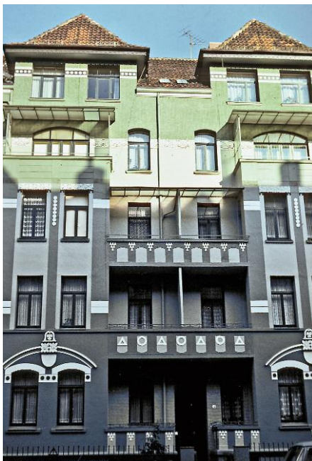
Modernisierter Altbau, Hannover 1978
