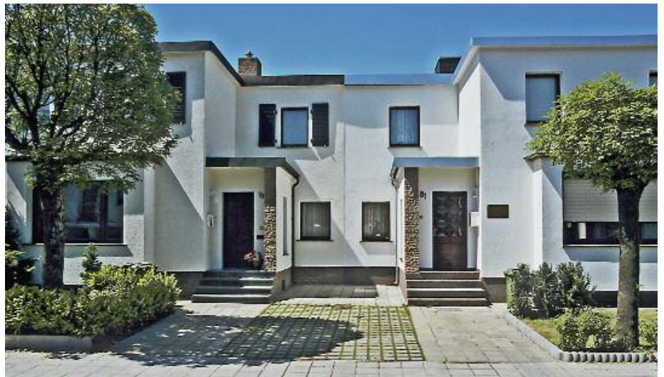
Siedlung Törten, Dessau, gebaut ab 1926 nach Planung von Walter Gropius, heutiger Zustand
