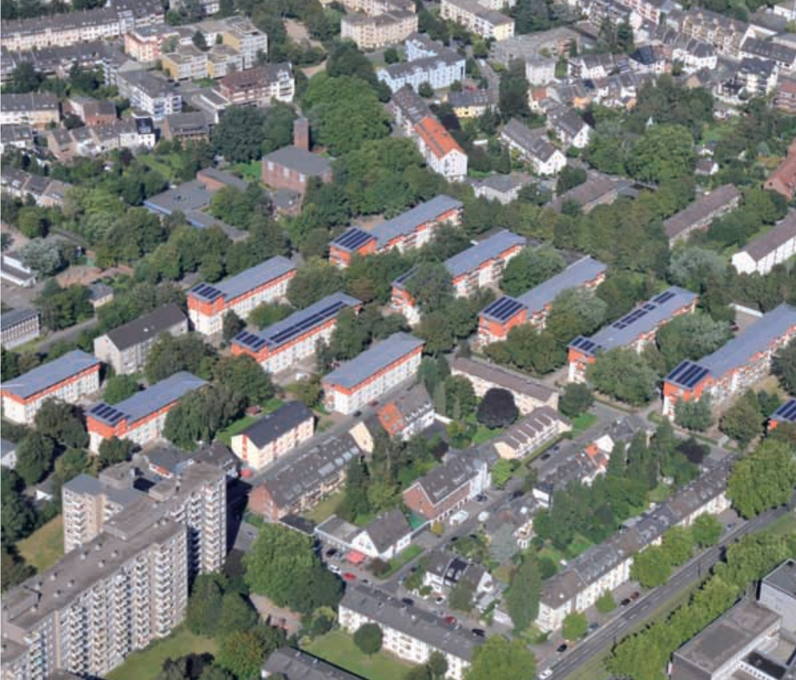
Mit der Dachaufstockung der Wohnsiedlung schufen die Architekten ARCHPLAN aus Münster mehr Wohnraum und Platz für eine Solarthermie-Anlage. Detaillierte Projektbeschreibung siehe: www.archplan.de
