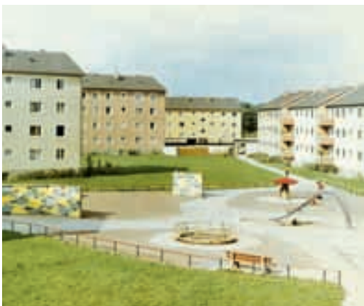
Foto aus den 1950/60er Jahren: Zeilenbauten und offene Freiräume
