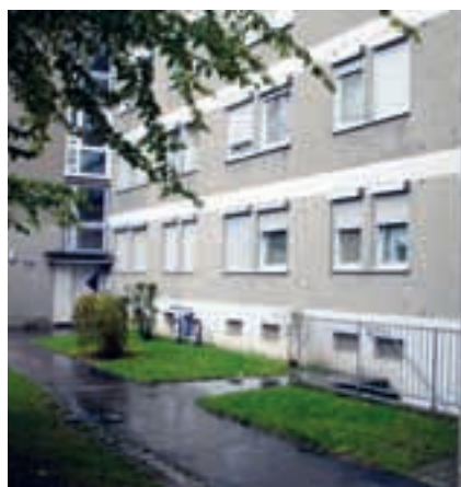
Vor der Sanierung: vernachlässigte Eingangsbereiche
