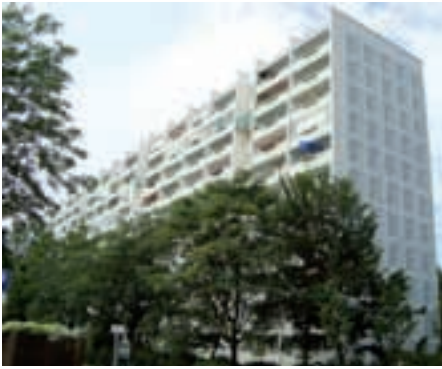
Saniertes Wohngebäude im Wohngebiet Frankfurter Allee Süd
