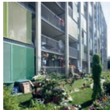
Die bestehenden Loggien wurden entfernt und durch großzügige Balkone ersetzt.
