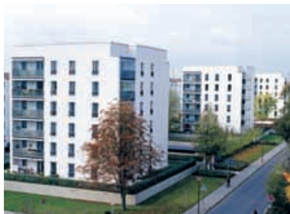
Für die barrierefreie Erschließung der Erdgeschossenebene und die Zuordnung von Terrassen und kleinen Mietergärten wurde das Gelände angefüllt und mit Stützmauern abgegrenzt.
