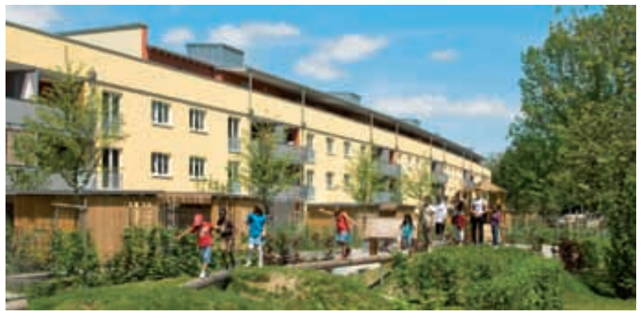
Das oberste Geschoss ist hofseitig um die Breite eines Laubenganges zurückgesetzt. Über diesen erreichen die Mieter zusätzliche Abstellräume.
