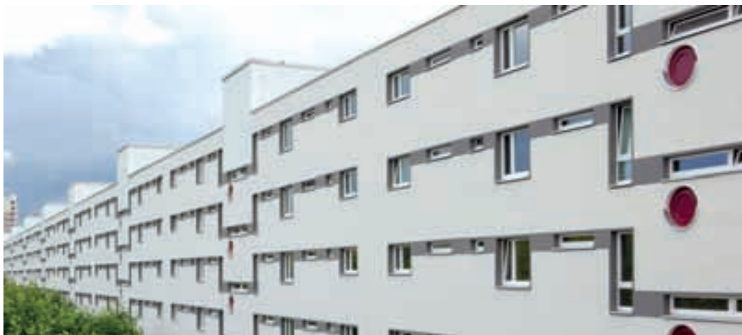
DENA-Modellvorhaben: weitgehende „warmmietenneutrale“ Komplettisanierung mit einer Qualität von 70 Prozent Neubaustandard EnEV 2009.
