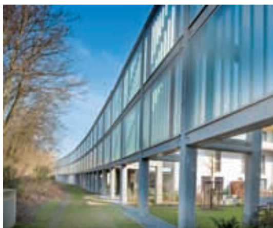
Die Wohnanlage wird durch in die Baukörper integrierte Lärmschutzwand erheblich aufgewertet.
