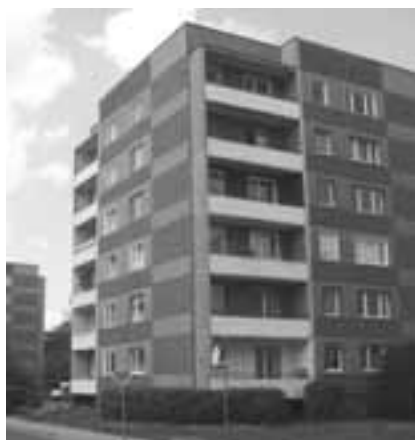
Bestandsgebäude vor der Sanierung
