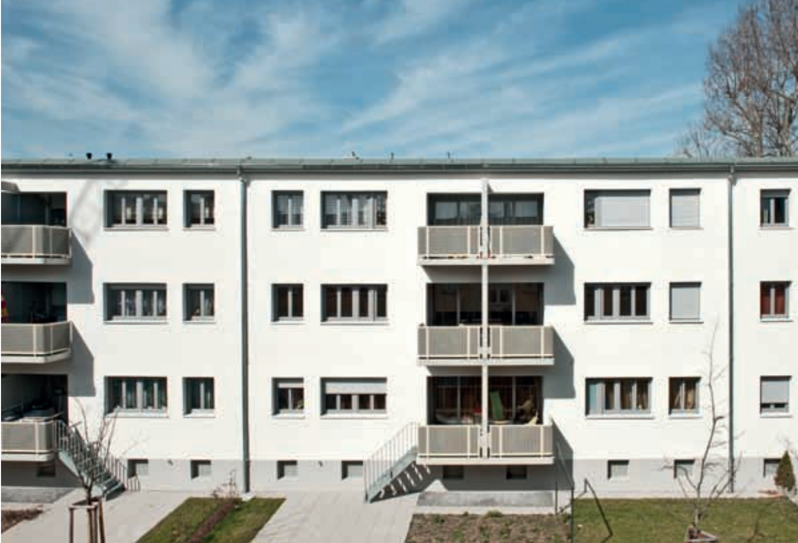
Zur Aufrechterhaltung der Fassadenproportionen wurde die Dämmstärke des Wärmedämmverbundsystems auf max. 8 cm festgelegt. Ausführliche Projektbeschreibung unter www.kaestleckerroeder.de
