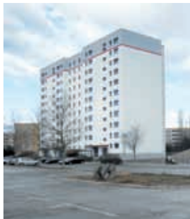
Zustand der Fläche nach dem Abriss des Elfgeschossers.
