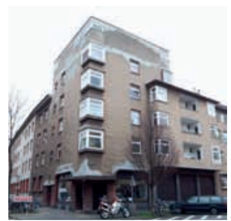
2006: stark sanierungsbedürftig; Beginn der tiefgreifenden Erneuerung
