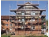
Sanierungsarbeiten in der Mülwiker Straße
