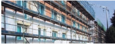
Bauliche Bestandssanierung 2009 in Göttingen-Leneberg
