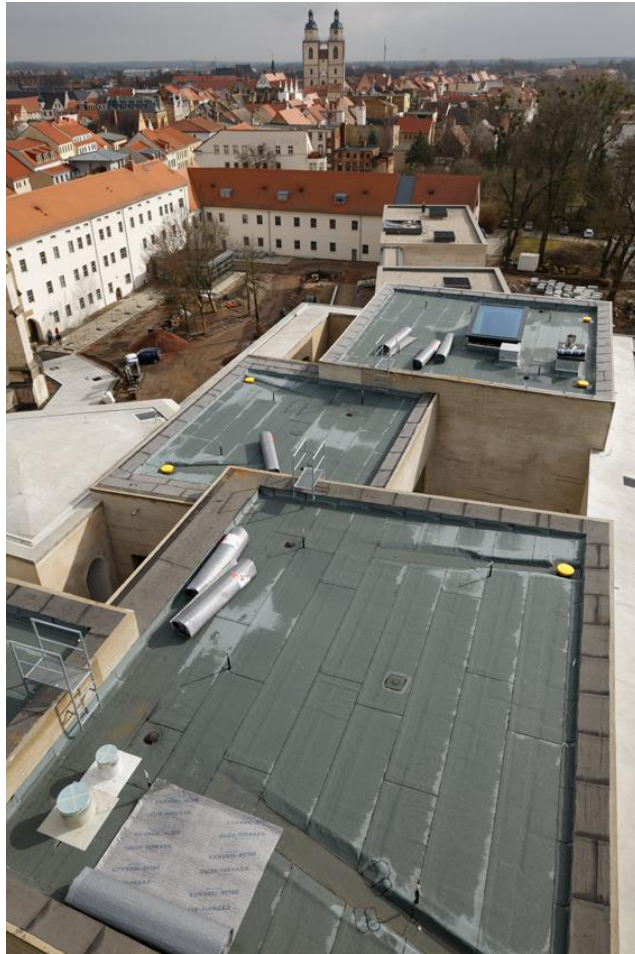
Blick vom Südturm auf das DG
