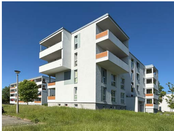
In Zeulenroda wird das Quartier Otto-Grotewohl-Ring in hoher gestalterischer Qualität umgebaut. Zwei Bauabschnitte sind fertiggestellt, ein dritter Abschnitt wegen gestiegener Baukosten bisher nicht umgesetzt
