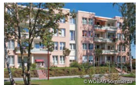
Neubau der WOBAG 2007/08 (Frohdorfer Straße 44a), Erschließung des benachbarten Gebäudes durch Aufzug und Laubengänge
