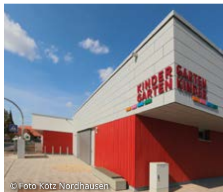
Der neue Kindergarten in der Gartenstraße
