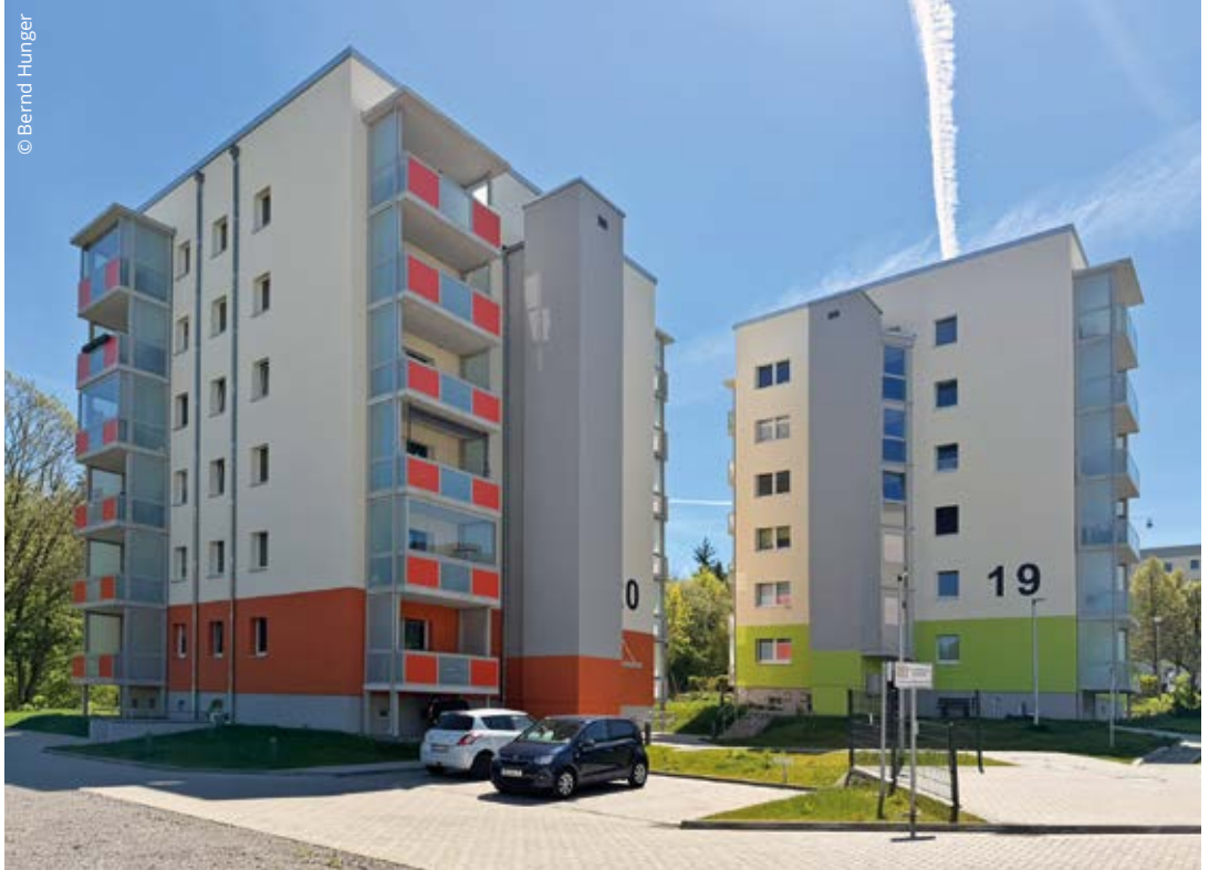
Am Tiergarten 19 und 20 nach der Sanierung
