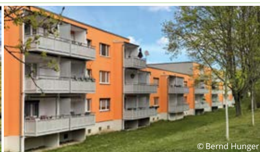
Das Gebäude in der Otto-Nuschke-Straße 1–8 wurde auf drei beziehungsweise teilweise zwei Geschosse zurückgebaut. Im Zuge des Umbaus erhielten alle Wohnungen einen Balkon.
