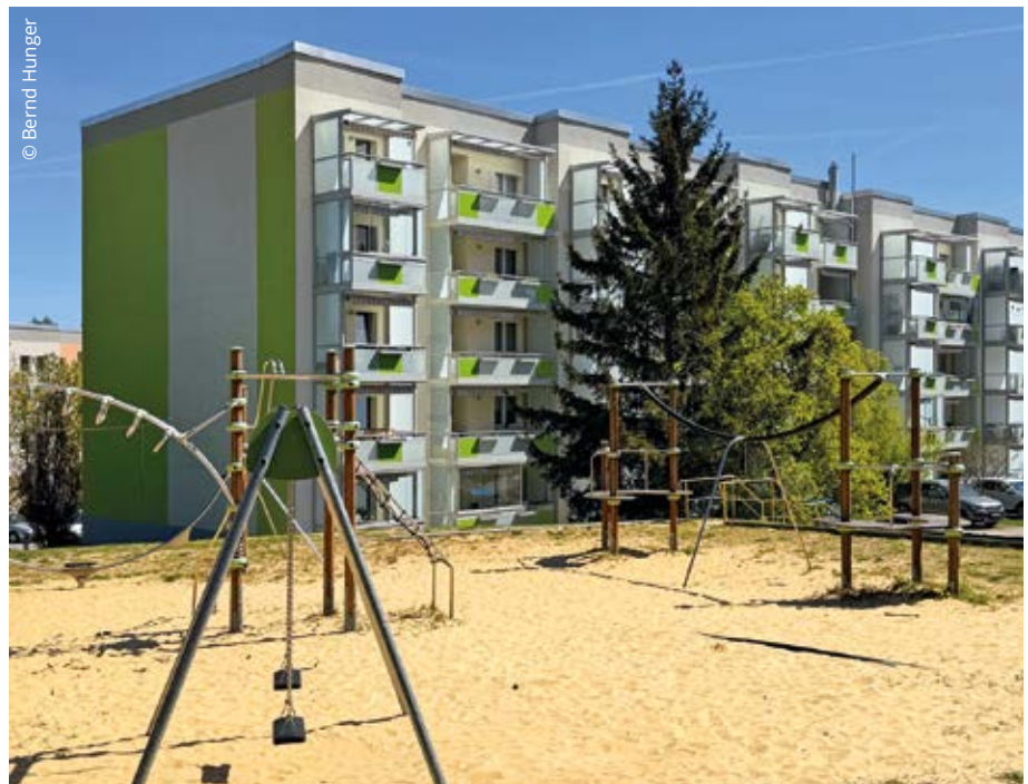
Die Zeile Am Tiergarten 6–10 ist eine von drei modernisierten Zeilen. Die Stadt hat mit einem neuen öffentlichen Spielplatz an zentraler Stelle zur Aufwertung des Quartiers beigetragen.
