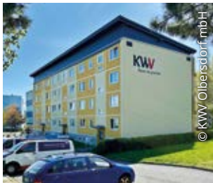
Gründach am Gebäude Zum Grundbachtal 37–41
