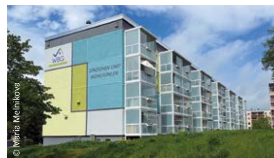
Teiltrückbauprojekt der Genossenschaft. Aus Gründen der Wirtschaftlichkeit wurde das vorhandene Dach wiederverwendet.
