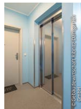
Der Aufzug Moskauer Straße 8
