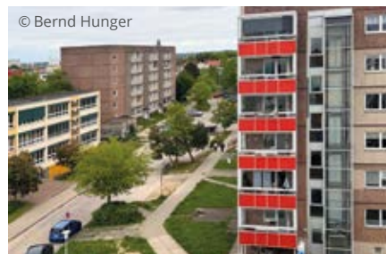
links: Fritz-Greve-Gymnasium, rechts: die Gebäude der Genossenschaft mit Fahrstuhlbanbau
