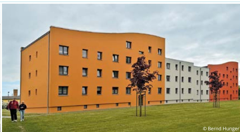
Das Umbauprojekt „Die Welle“ ist von seiner Gestaltqualität her ein „Hingucker“ geworden. Die ener- getische Sanierung reduzierte den Primärenergiebedarf auf 32 kWh/m 2 .
