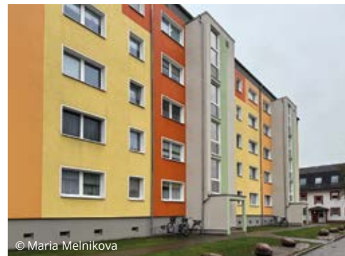
Chausseestraße 15–17: Die Aufzüge wurden an den Bestand angebaut und über Zwischenpodeste mit dem Treppenhaus verbunden.
