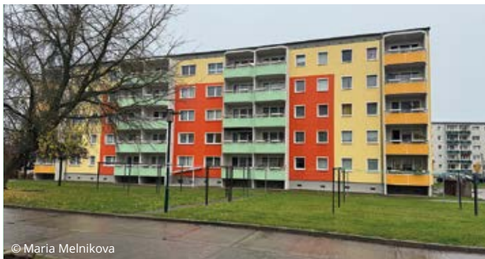
Straße der Republik 33–35: Anbau von Aufzügen sowie Erneuerung von Balkonen und Gebäudehülle. Die farbige Fassadengestaltung hat das Bild des Quartiers aus Bewohnersicht positiv verändert.
