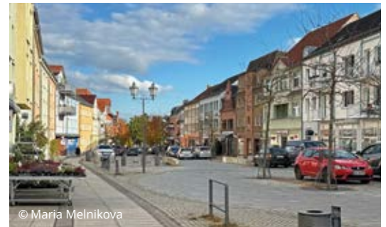
Die umgebaute Cottbuser Straße
