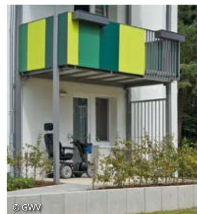
Barrierefreie Erschließung der Erdgeschosswohnungen durch Geländemodellierung
