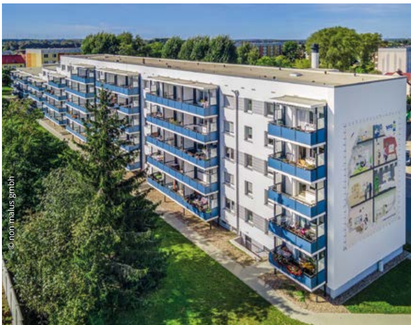
Nünchritz, Umbauprojekt Karl-Liebnecht-Ring 1-7
