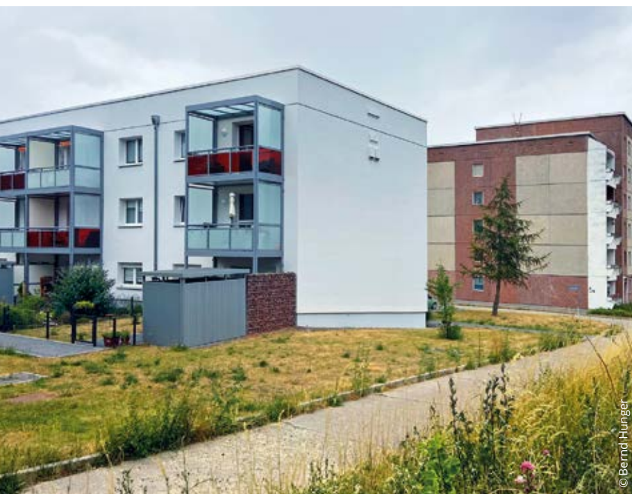
Hettstedt, Teiltrückbau im WK IV
