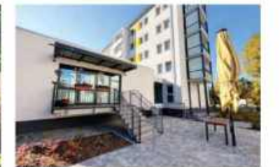
Die WIS Wohnungsbau genossenschaft im Trossener Wald realisierte als Auftakt ihres Engagements in Vetschau den barrierefreien Umbau eines Wohnhauses mit Treppenzugang © Maria Meixner
