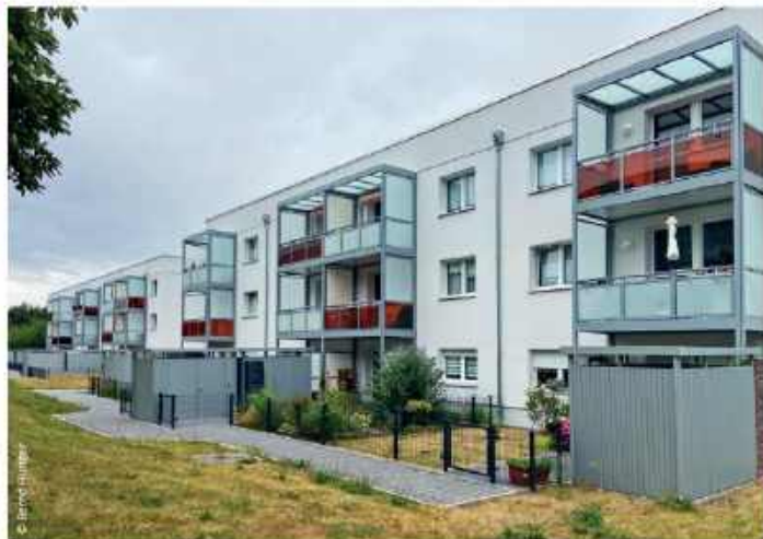
Lärchenweg 1-6 hat die Woges 2023 zu zwei dringeschossigen Gebäude umgebaut. Die nachgefragten Grundrisse erhielten unter anderem größere Bäder.
