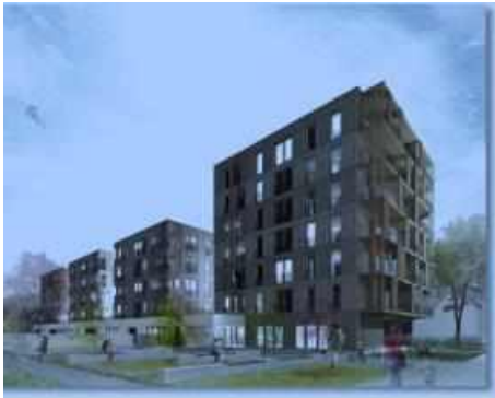
Neubau in Holzbauweise (Bild: GWG)
