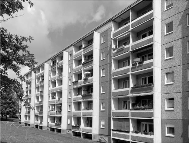
**Abb. 7: Typisches Wohngebäude in Plattenbauweise vor der Sanierung.**
