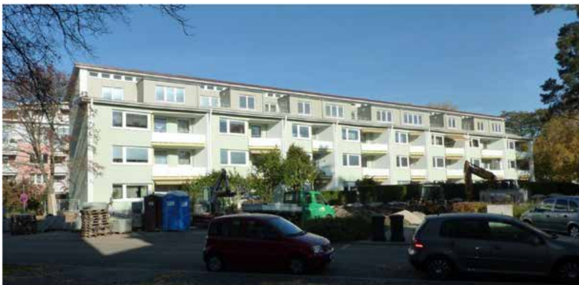
Beispiel Parkwohnanlage West, Nürnberg
