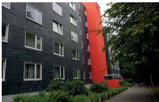
Viele Gebäude in der Hustadt sind mit Schieferfassaden verkleidet.
