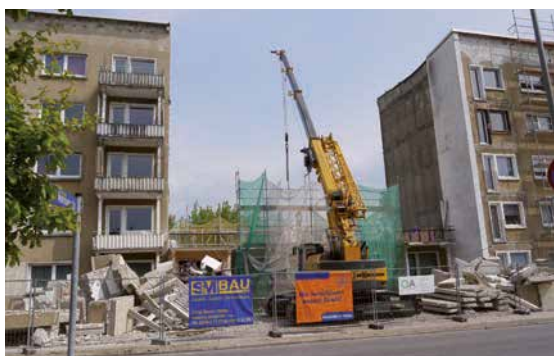
Wohnblock Carl-Moltmann-Straße – der Teilabriss eines Treppenaufgangs...
