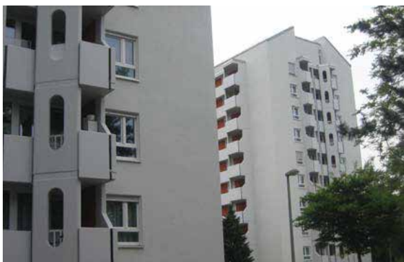
Die Punkthäuser nach erfolgter Sanierung.
