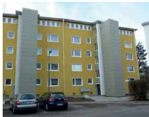
Bei den höhergeschossigen Gebäuden wurde im Rahmen der Modernisierung ein Aufzug angebaut.
