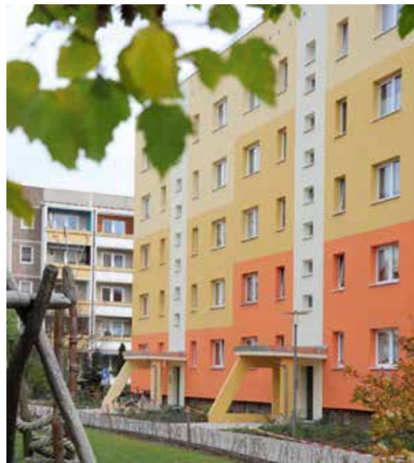
Mehr Wohnkomfort, mehr Grün und mehr Lebensqualität: Sanierte Gebäude in einem von vier Wohnungsunternehmen gemeinsam umgestalteten Wohnhof.
