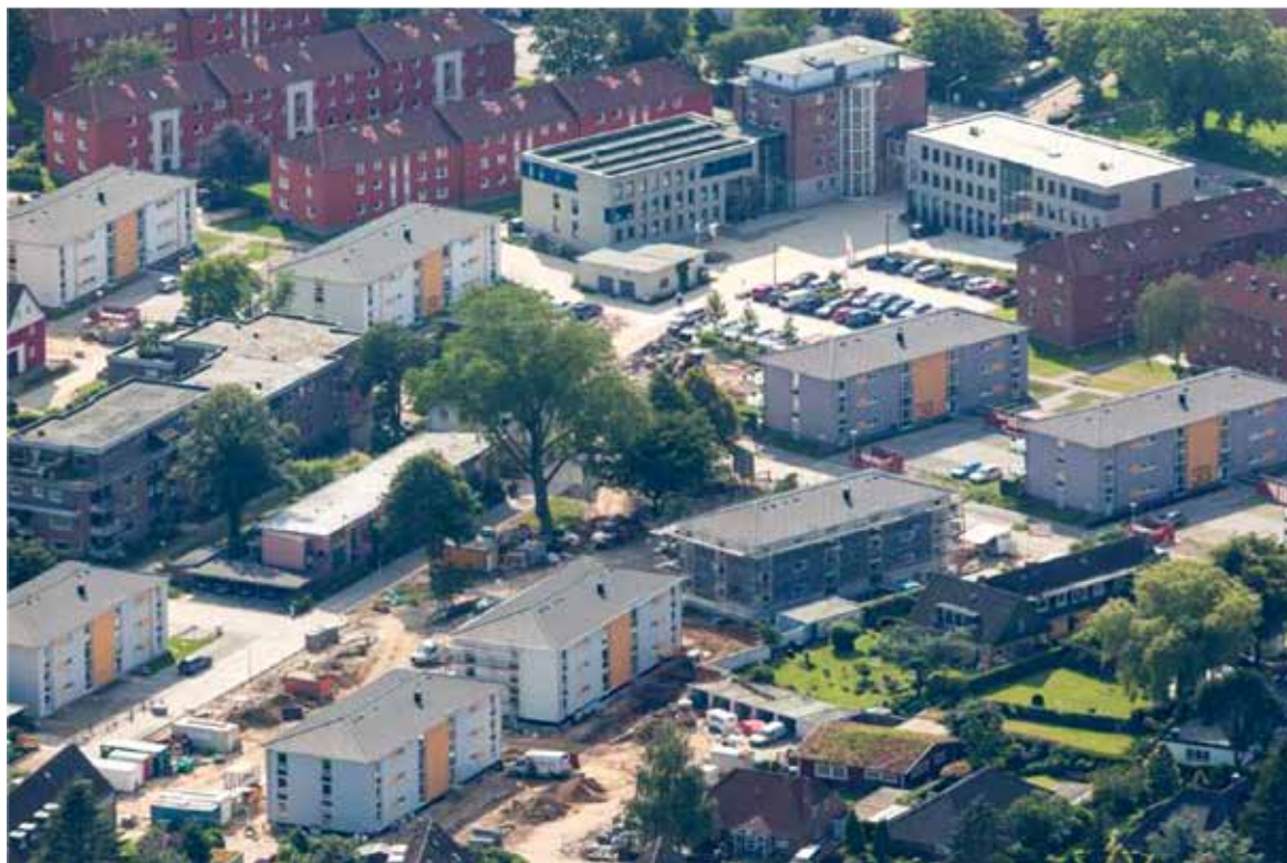
Wohnungsneubauten und neues Gemeinschaftshaus direkt neben dem Verwaltungsgebäude des SBV.
