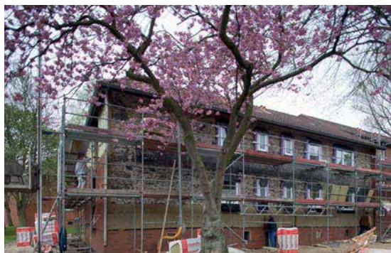
Die Sanierung schreitet in Fruehlund zügig voran.
