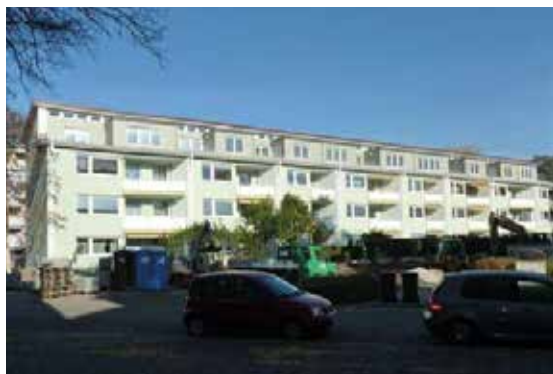
2011 wurde die erste Gebäudezeile unter Denkmalschutzanforderungen saniert und aufgestockt.
