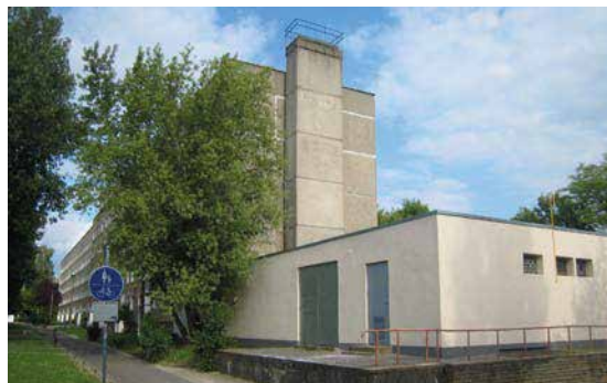
Das Gebiet wird über Nahwärmenetze mit einzelnen Heizzentralen versorgt.
