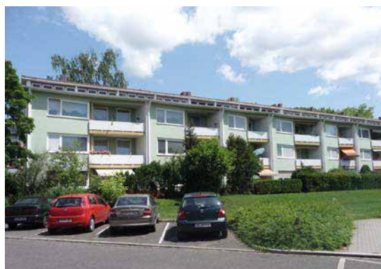
Das Gebäude der Nachkriegsmoderne mit moderater Dichte bieten eine hohe Wohnqualität.
