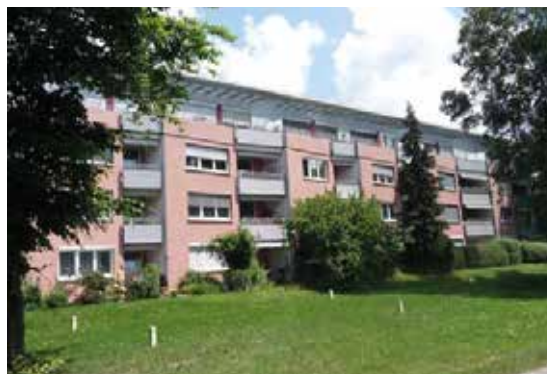
Bereits 2006 wurde ein Objekt in der Bernadottestraße modellhaft saniert und aufgestockt – seinerzeit ohne Auflagen des Denkmalschutzes.
