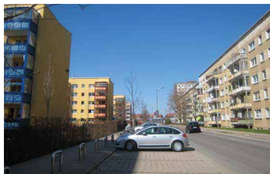
Sanierte und unsanierte Bestände stehen in Waren West dicht nebeneinander.
