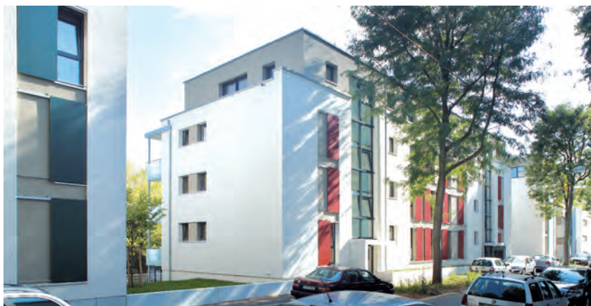
Ersatzneubau für einen langen durchgehenden Gebäuderiegel
