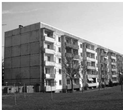
Plattenbauzeile vor der Modernisierung
