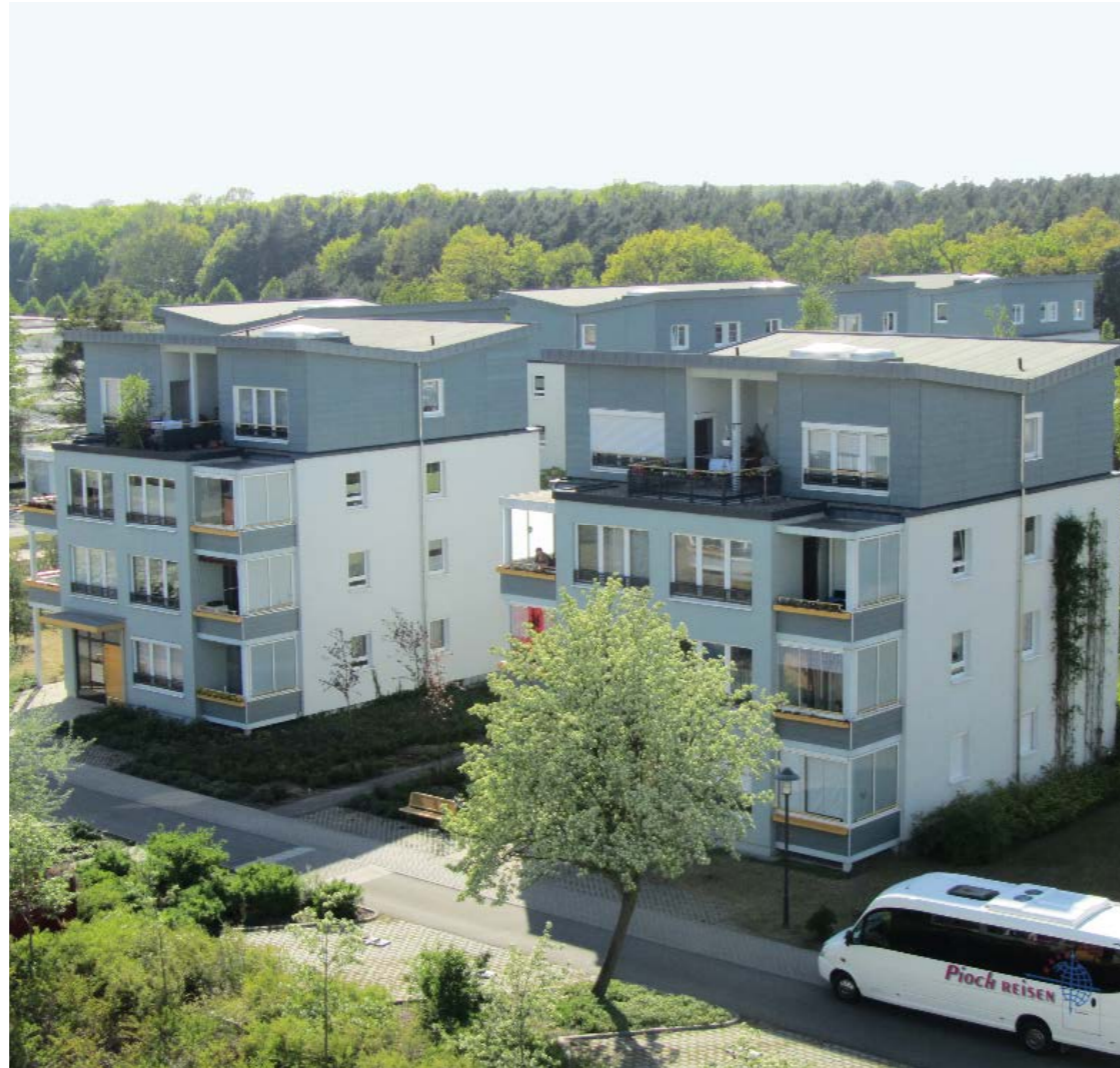
Schwedt, Komplexer Stadtumbau: 3. Bauabschnitt: Errichtung von Stadtvillen; Rückbau auf drei Geschosse; Demontage von Fassadenplatten, Anbau neuer Vorbauten für Wohnzimmer; Bau eines Staffelgeschosses für Wohnungen mit Dachterrassen; Anbau neuer Balkone
