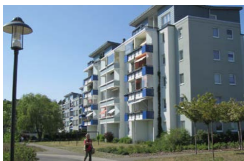
2. Bauabschnitt: Aufbau eines Staffelgeschosses, Dachterrassen und Aufzugeinbau
