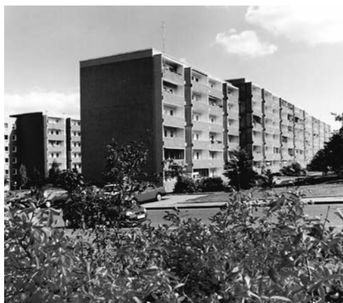
Wohnblock vor der Modernisierung im Jahr 2002
