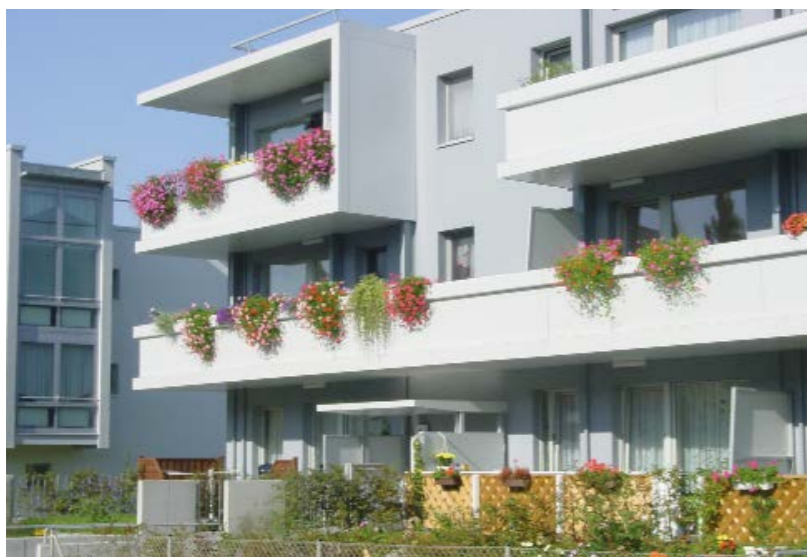
Dresden, Kräutersiedlung: Das äußere Bild veränderte sich durch eine Neugestaltung der Balkone und Terrassen. Das Außengelände wurde angehoben und den Erdgeschosswohnungen je ein Mietergarten zugeordnet.
