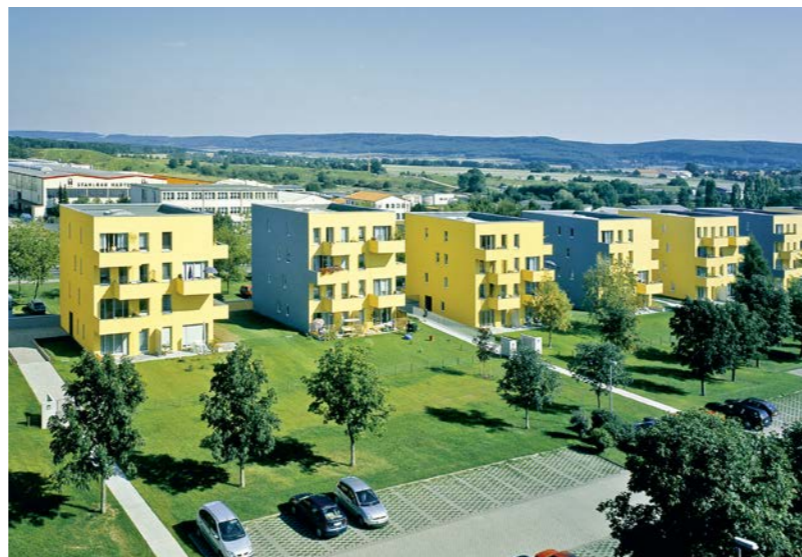
Leinefelde, Einsteinstraße: Umbau einer Plattenbauzeile zu acht Stadtvillen.
