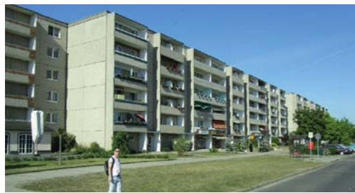
1. Bauabschnitt: Umsetzung der üblichen Instandsetzungs- und Modernisierungsleistungen
