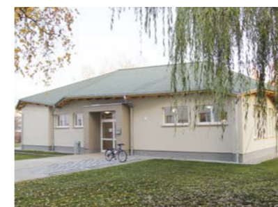
Der ehemalige Wäschestützpunkt wurde zum Kindertreff umgebaut.
