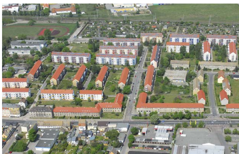
Wittenberg-West, Wohnsiedlung der 1920er bis 1960er Jahre: Beispielhaft ist das Zusammenspiel von energetischer Sanierung mit Berücksichtigung des demografischen Wandels und vielfältiger Gemeinwesenarbeit.
