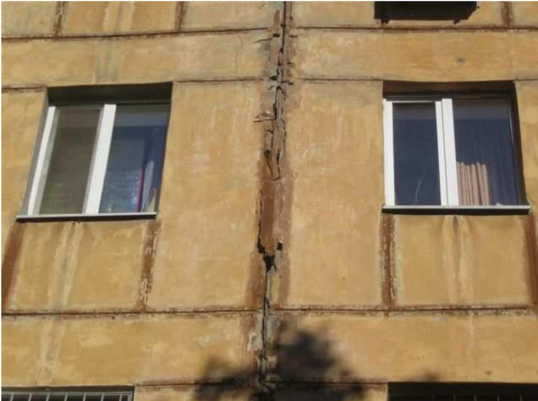
Bild: Typische Schäden an einer Hausfassade in Dnepropetrowsk
