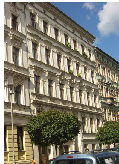
Gebäude nach Sanierung
