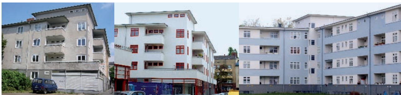
vor der Sanierung
