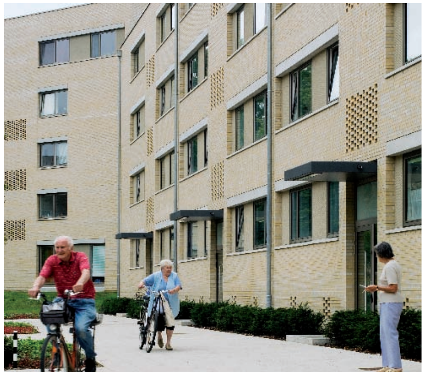
Die Hauseingänge im Altbau Süd wurden alle erneuert, im Hintergrund der Neubau
