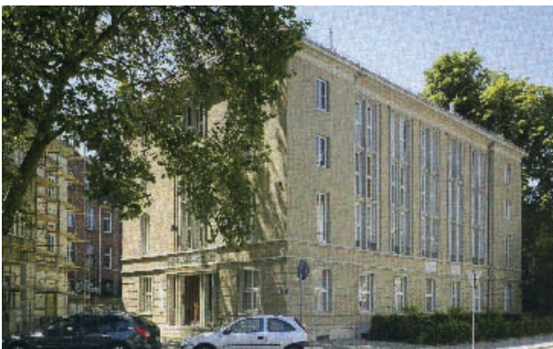
Erfurt, Alter Hörsaal Erfurt, Gorkistraße Umnutzung und energetische Sanierung, 1950er Jahre Bauherr: Eigentümergemeinschaft Lindenlaub Rommel, Erfurt Architekt: hks Hestermann Rommel, Erfurt
