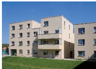
Hofseitig ist der barrierefreie Zugang möglich
