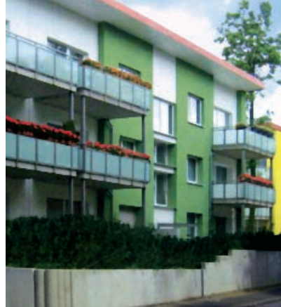
Bochum, Vogelsiedlung Wohnsubstanz 1950er Jahre Bauherr + Architekt: VBW Wohnen+Bauen GmbH, Bochum
