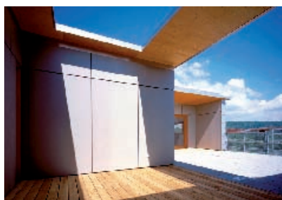
Die großzügige Dachterrasse lockt neue Mieter ins Haus
