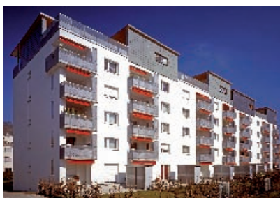
Aufstockung mit hochwertigen Penthousewohnungen
