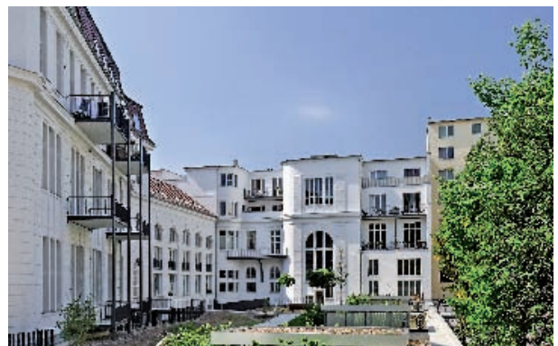
Berlin, Witzlebenplatz Sanierung und Umnutzung des Alten Kammergerichts Bauherr: Kondor Wessels Berlin, Berlin Architekt: RVB Witzlebenstraße GmbH & Co. KG, Berlin
