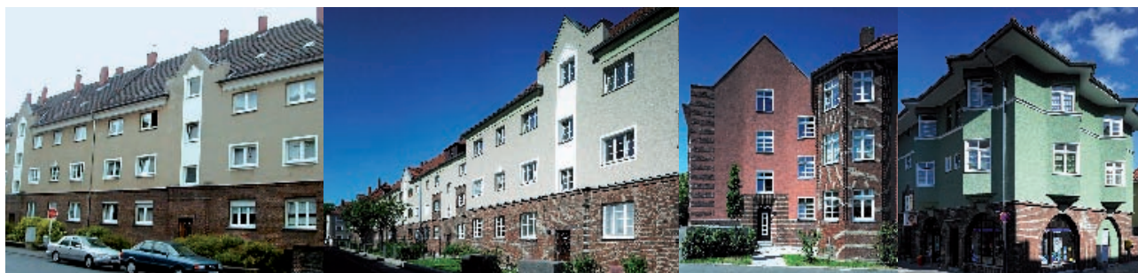
vor der Sanierung
