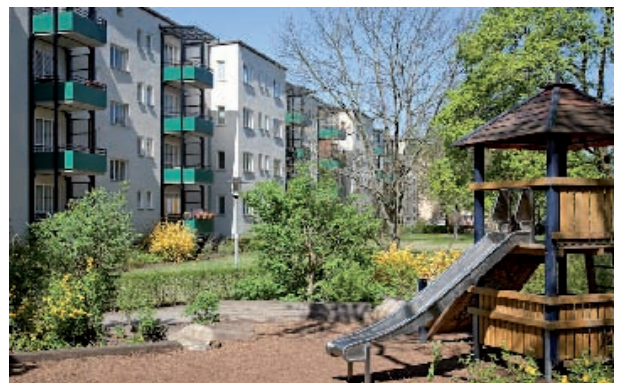
Berlin, Reichsforschungssiedlung Haselhorst Modernisierung Wohnsubstanz 1920er Jahre Bauherr: GEWO BAG Gemeinnützige Wohnungsbau-AG Berlin Architekt: Garsztecki & Hartmann, Berlin
