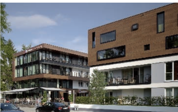
Münster, "Wohnen am Aasee", Bismarckallee Sanierung und Umgestaltung der Studentenwohnheime Bauherr: Studentenwerk Münster AöR, Münster Architekt: behet bondzio lin architekten GmbH & Co. KG, Münster
