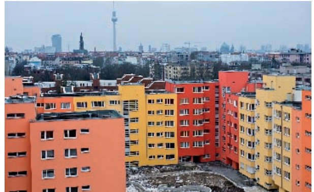
Berlin, "Hofgarten" Modernisierung Großsiedlung Bauherr: degewo, Berlin Architekt: S+P Betreuungs- und Verwaltungsgesellschaft, Berlin
