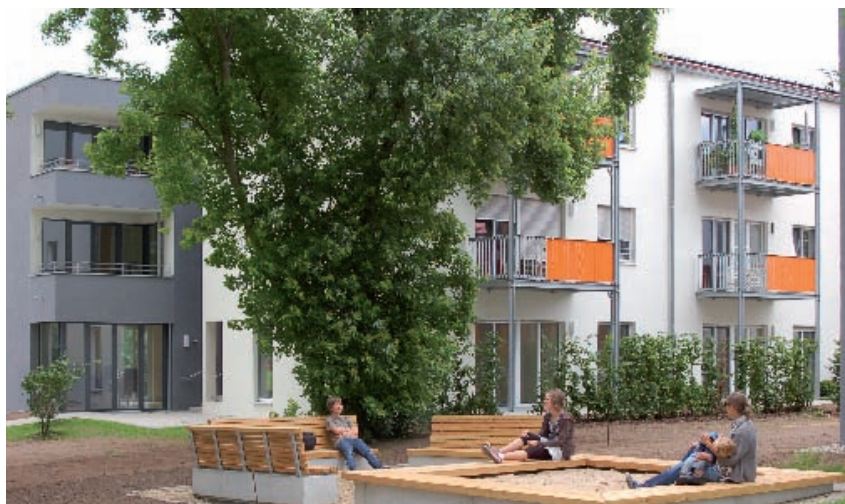
Die Gebäudezeilen wurden durch neue Laubengänge, Aufzüge, Balkone und zusätzliche Gebäude ergänzt
