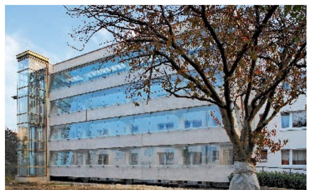
Bremerhaven, Weiterbau statt Abriss, Schillerstraße Modernisierung und Umbau Wohnsubstanz 1950er Jahre Bauherr: Städtische Wohnungsgesellschaft Bremerhaven mbH Architekt: Hans-Joachim Ewert mit Bauherr, Bremerhaven
