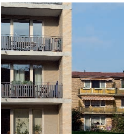
Fassadendetail, unsanierter Altbau im Hintergrund
